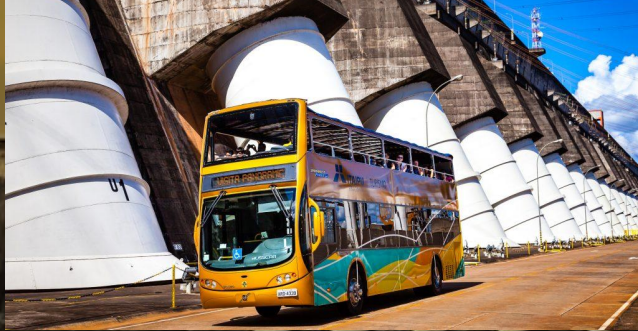
Central Hidroeléctrica ITAIPU
